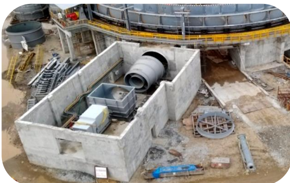
COOLING AIR FAN
